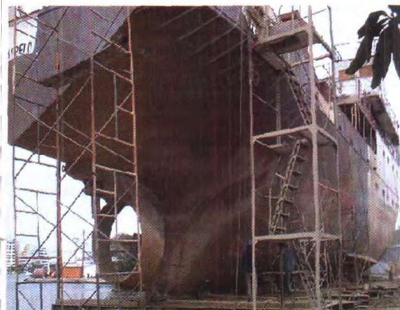
Reparación ARC Malpelo, Astillero Cotecmar - Cartagena
