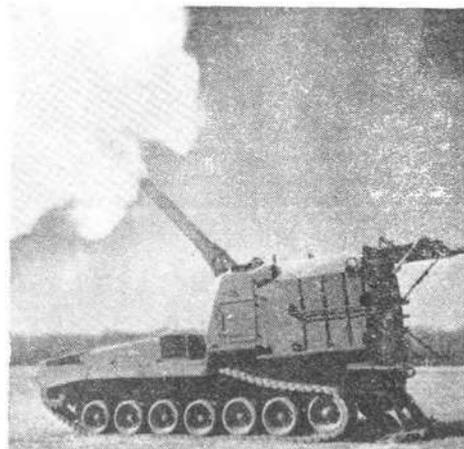
Figura 15-3 — Obús standar de 8 pulgadas M55 autopropulsado con cabina blindada para la tripulación.
