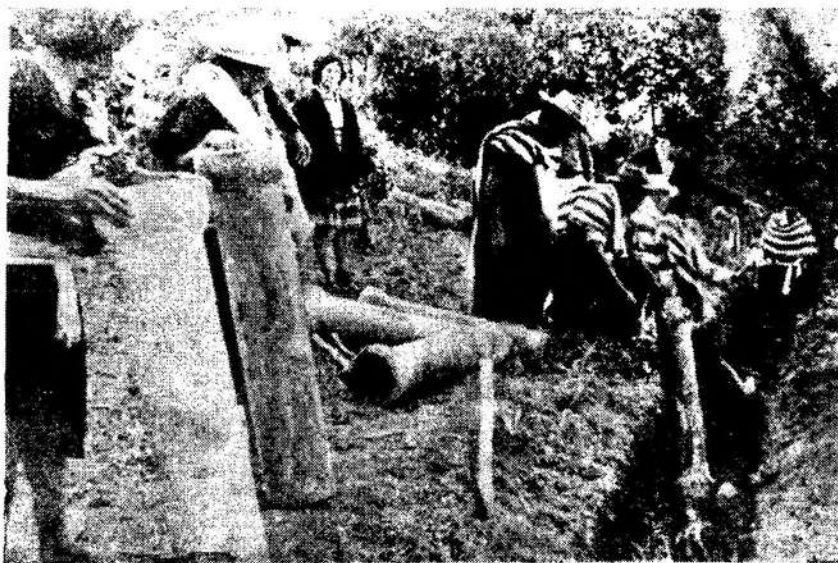
Indígenas Ingás adelantan por acción comunal la construcción de un alcantarillado. (Foto: R. Giacometto).
