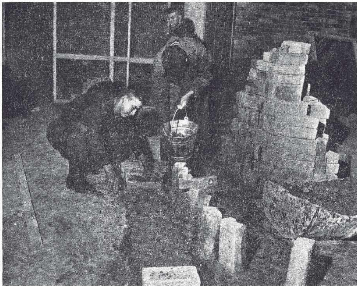
Soldados del Arma de Ingenieros en clase de construcción en el SENA.
