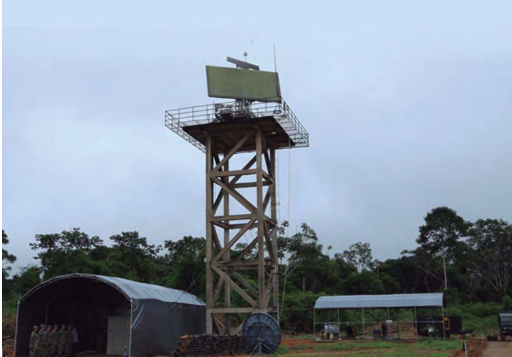
Foto: Radar TPS-70 de la Fuerza Aérea del Perú desplegado para efectuar operaciones de vigilancia, control y defensa del espacio aéreo contra el narcotráfico en la selva. Fuente: Fuerza Aérea del Perú.
