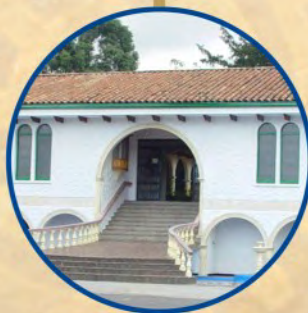
El Comando General de las Fuerzas Militares acepta la generosa donación de un edificio construido por la Fundación Duque Grisales, para la Biblioteca Central de las Fuerzas Militares
