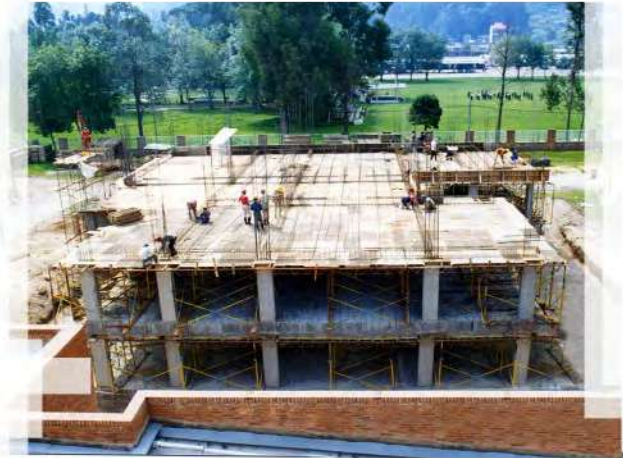
Construcción aulas Escuela Superior de Guerra
