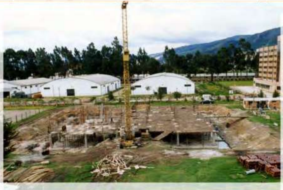
Construcción del actual Edificio Administrativo de la Escuela Superior de Guerra
