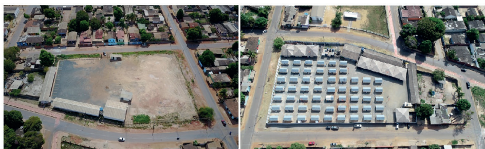
Figura 9. Construcción de un refugio en 10 días, con capacidad para 380 personas.
